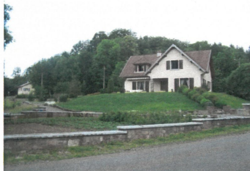
Construction sur remblais à BELONCHAMP
