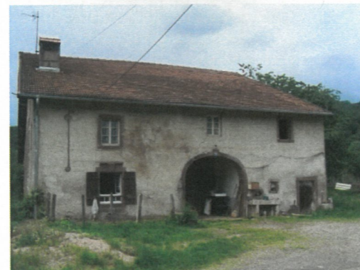
Fermes à réhabiliter au Damont
