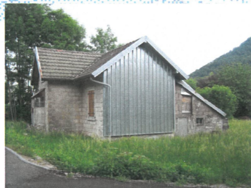
Maison sans valorisation du parcellaire
