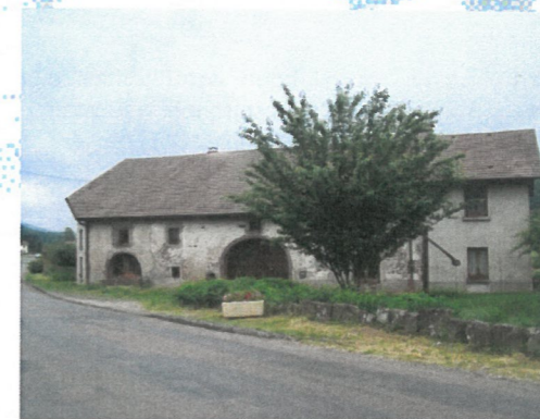
Construction ancienne à BELONCHAMP
