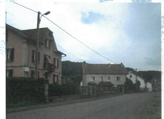
Mur bahut le long de la RD 486
