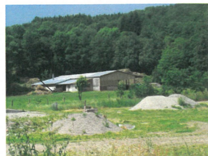
Bâtiment agricole générant un périmètre de réciprocité à la sortie de BELONCHAMP
