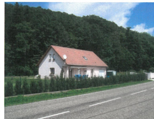
Construction récente au Raddon
