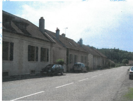
Ancienne cité ouvrière
