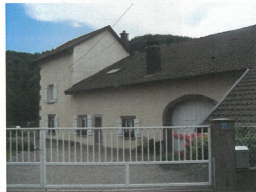
Anciennes ferme rénovée au Damont
