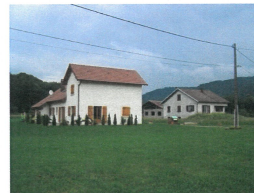
Absence de clôture autour de la parcelle
