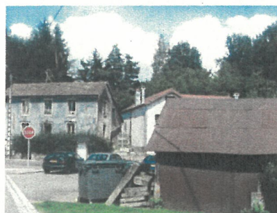
Constructions recouverte d'un bardage en tôle au centre de BELMONT
