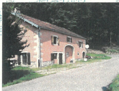
Construction ancienne rénovée le long de la RD 292
