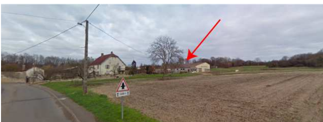
Bâtiment agricole de stockage (fourrage, paille...)
