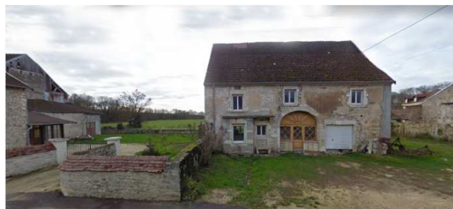
Bâti ancien Rue Fontenis. Des transformations importantes des ouvertures qui dénaturent l'architecture originelle
