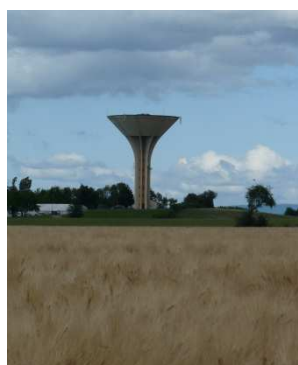
Château d'eau La Garenne
