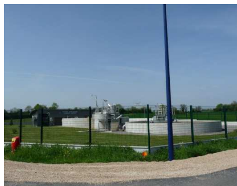
Station d'épuration de Colombier Saugnieu
