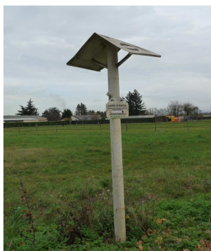
Borne du pipeline Sud-Européen
