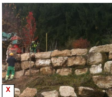
Enrochement de type cyclopéen
