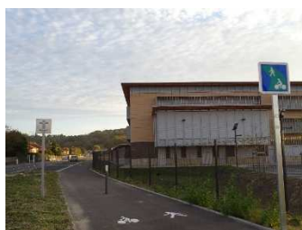
Aménagement du chemin de la Madone
