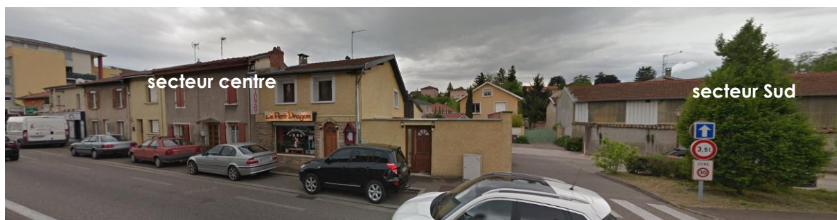
Secteurs centre (à gauche) et Sud (à droite) : vue depuis la RD306 au niveau de la place du Paleyron
