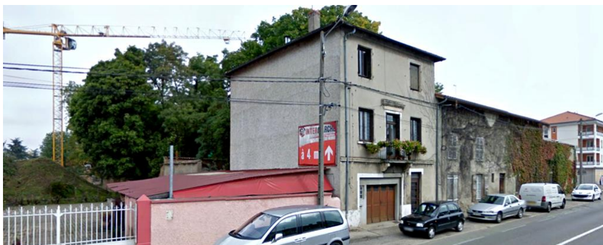
Secteur Nord : vue depuis la RD306
