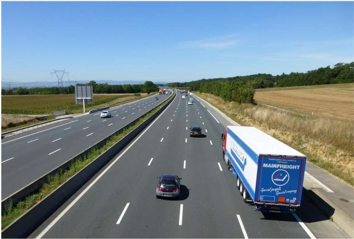
L'autoroute A43, source de pollution de l'air.
