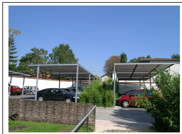
Espace public et stationnement
