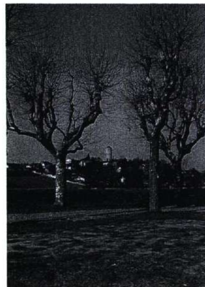
Le Château d'eau
