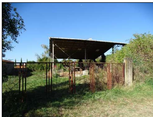
Charpente métallique du hangar agricole caractérisant le bas du site.
