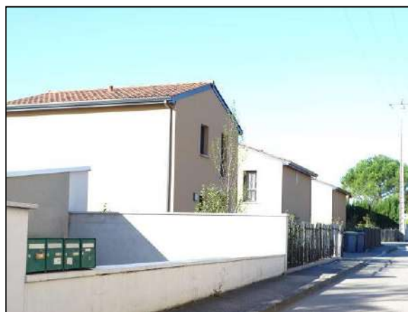
Ensemble immobilier récent - rue du Mazet
