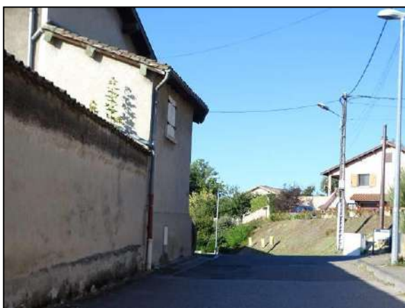
Bâti ancien - rue du Mazet
