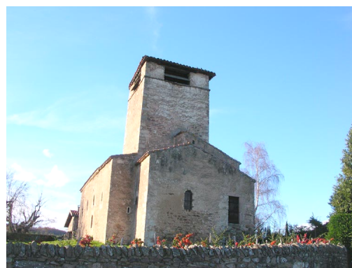
Vue est sur l'abside et le clocher
