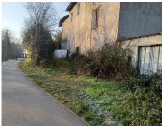
Entrée Sud-Est actuelle
