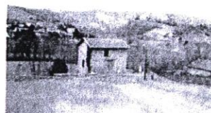
Accès sur RD385 en entrée de village
