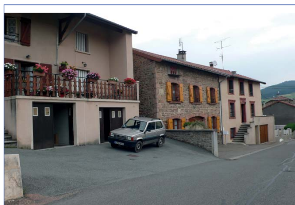
Rampes d'accès aux garages
