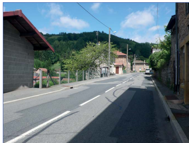
Hameau sous forme de village-rue
