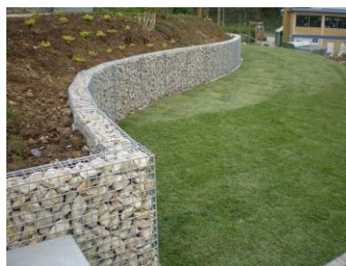
Muret en gabion
