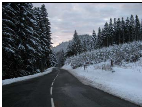
Vue de la RD9, à l'est de la commune
