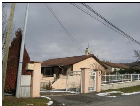
Pavillons dans le hameau du Collier
