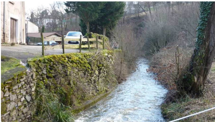
◀ Aperçu du mur ventru en rive gauche du quartier de RENAVELIERE
