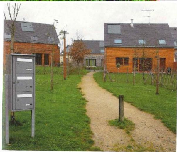
Accès prédominant aux logements
