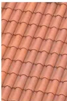
Toiture de tuiles romanes
