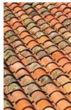
Toiture de tuiles creuses
