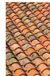
Toiture de tuiles creuses
