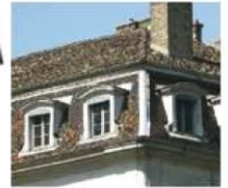
Toit «à la Mansart» en tuiles plates
