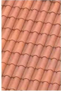
Toiture de tuiles romanes
