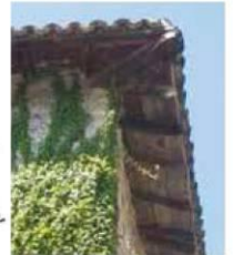
Forget débordant ancien, sans gouttière
