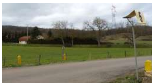
Canalisations de gaz près de La Barollière
