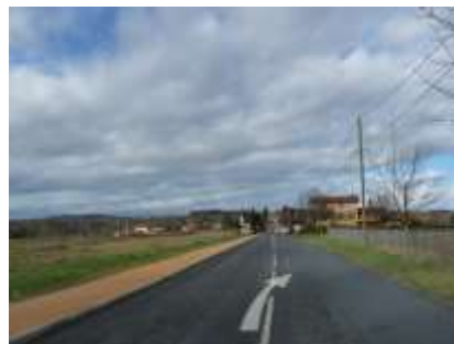
Aménagement d'un trottoir à l'entrée du bourg de Saint Germain
