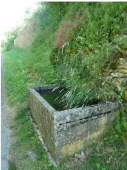
Lavoir sur le chemin des Carrières
