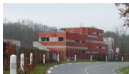
Station d'épuration dite de l'Arbresle
