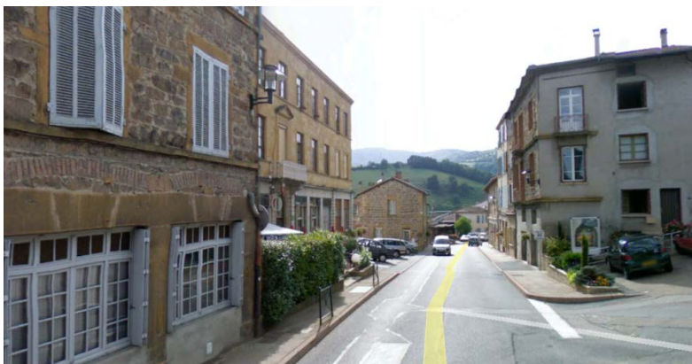
Les perceptions guidées par les alignements bâtis dans le bourg
