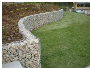
Muret en gabion
