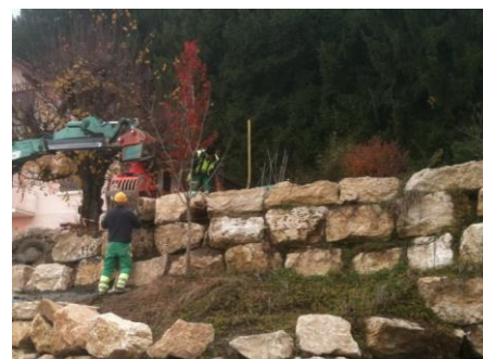
Enrochement de type cyclopéen
