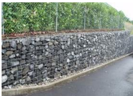
Muret en gabion
