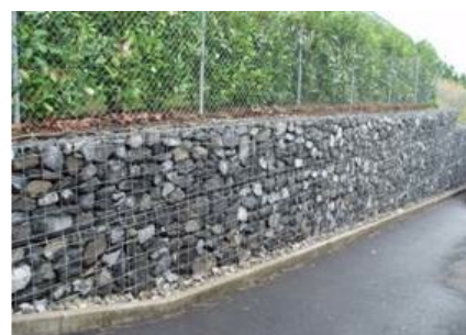
Muret en gabion
