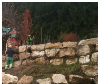
Enrochement de type cyclopéen
