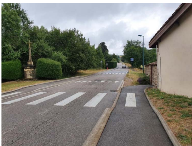
Aménagements sécuritaires réalisés sur la RD 121
