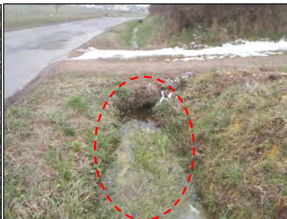
Joint cassé au droit d'un regard d'eau pluvial de la route de Saint-Romain
