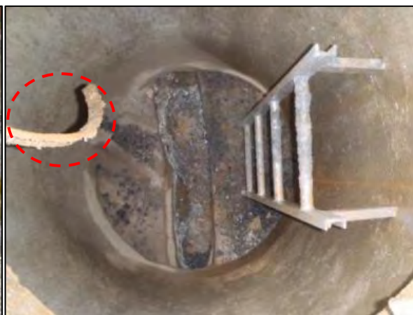
Joint cassé au droit d'un regard d'eau pluvial de la route de Saint-Romain
