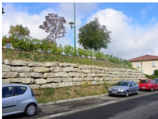
Route de Fondrieu
