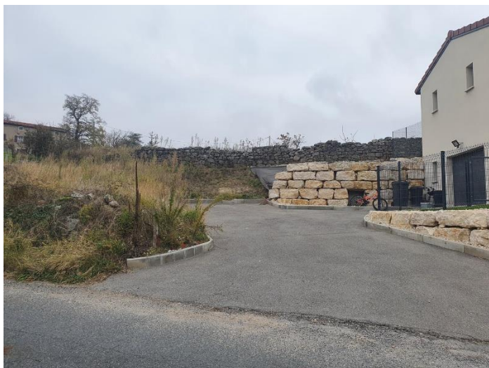
Accès aménagé à la zone économique
