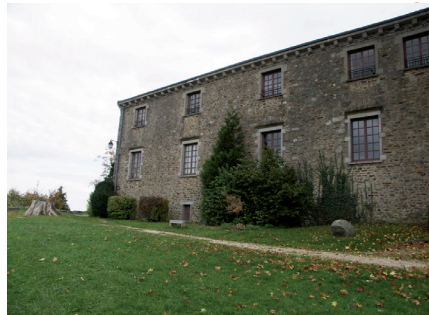
LE CHATEAU façade sur cour et façade nord
