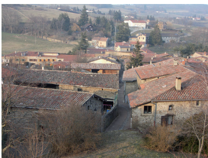
LES TOITS DE RIVERIE vus de la terrasse du château
