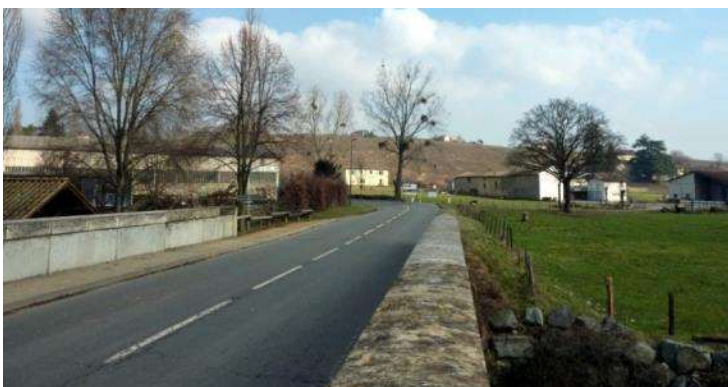
Le franchissement de l'Ardières
