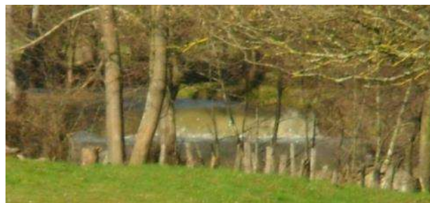
Seuil infranchissable sur l'Ardières
