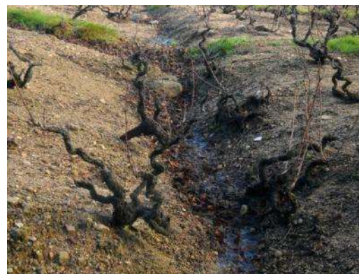
Absence de couverture végétale entraînant une érosion et un ruissellement
