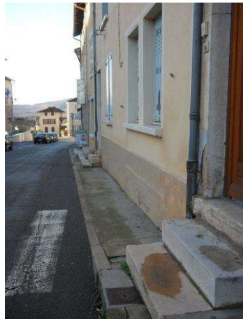
Trottoir de la rue du centre : nombreux obstacles pour des personnes à mobilité réduite
