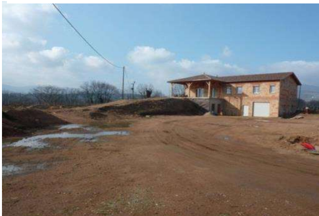
Construction d'habitation au Chastys
