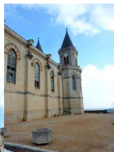
L'Église et son belvédère, façade Sud
