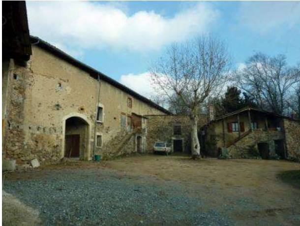
Habitation avec charpentes à poteaux
