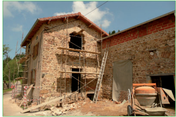
Construction en rénovation
