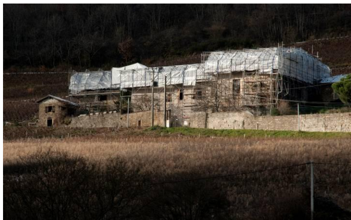
Cime d'Huire – réhabilitation d'un corps de ferme
