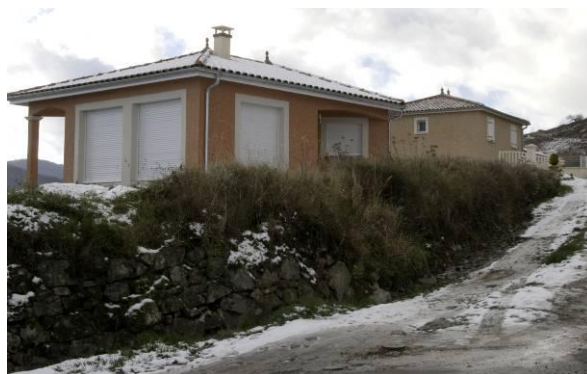
Construction neuve sur promontoire
