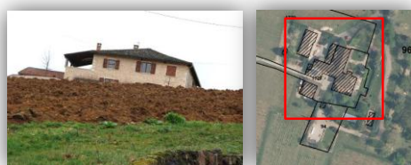
29. EBP 2. siège d'exploitation actif– Chalier
