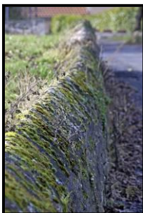
192 – mur au chemin de St-Pré
