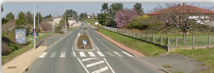
2. Entrée Sud et Est par Anse
