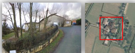
28. EBP 2. siège d'exploitation actif - Chalier
