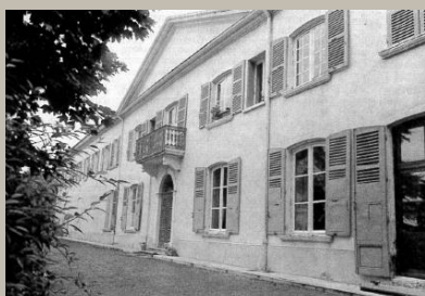
Pommerieux – façade Ouest
