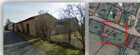
35. EBP 2. anc. bâtiment agricole – les Bruyères
