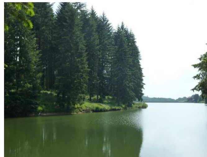
Barrage de la Gimond
