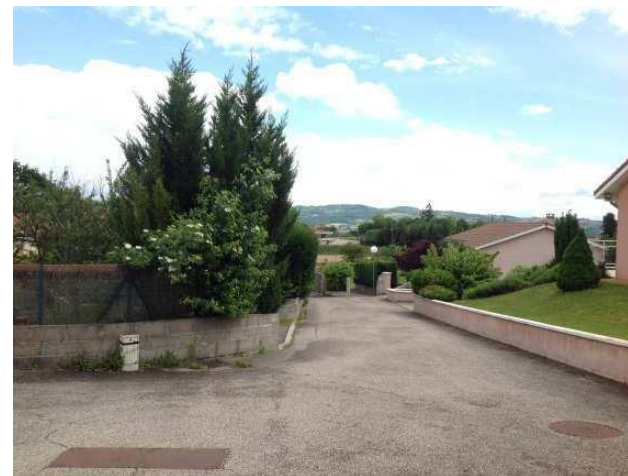
Voies en impasse dans le lotissement Le Panoramic
