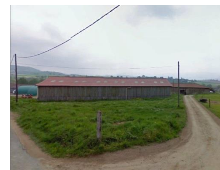
Bâtiment CUMA et tunnels
