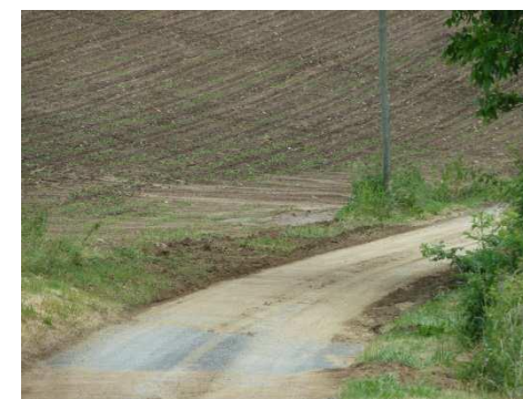
Présence de boue sur une route liée au ruissellement
