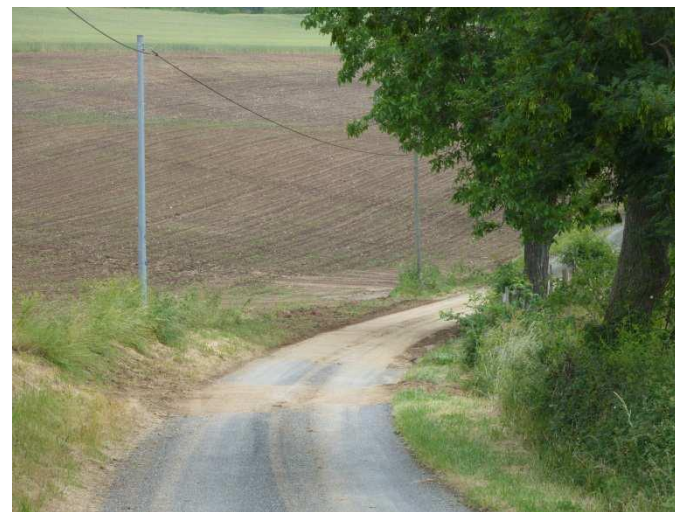
Secteur Les Ormes – Absence de haie et route fortement impactée après un fort épisode orageux
