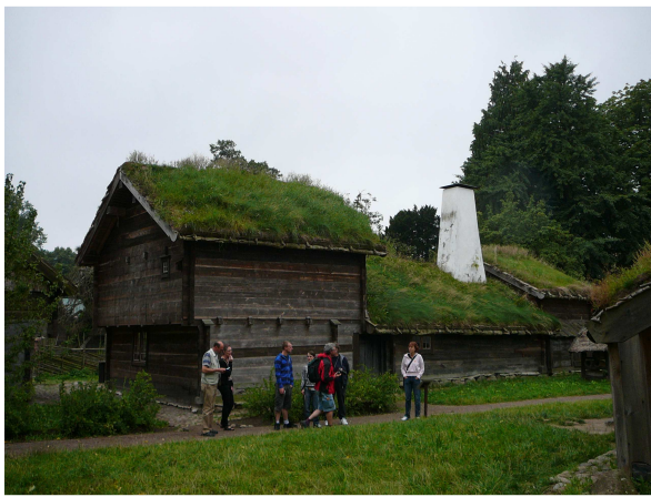
Toiture végétalisée et architecture « traditionnelle »
