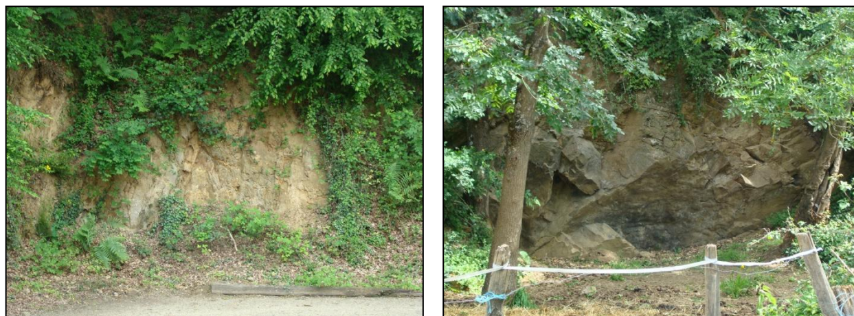
Figure 12 : Talus rocheux en bordure de la route de la Fontaine (à gauche) et à proximité de la route de de la Durantière, au niveau du Mont (à droite) [Source : IMS RN ]
