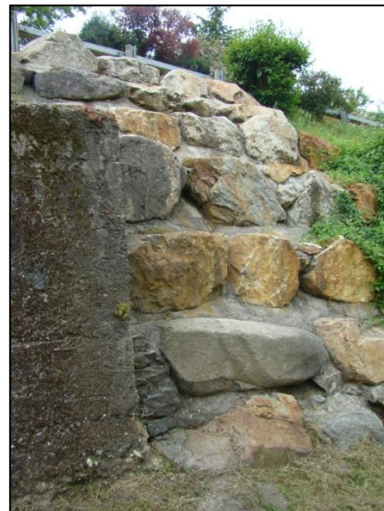
Figure 22 : Mur de soutènement et enrochement en aval de la RD 36 E [Source : IMS RN ]
