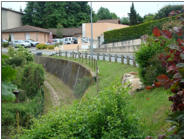
Figure 22 : Mur de soutènement et enrochement en aval de la RD 36 E [Source : IMS RN ]
