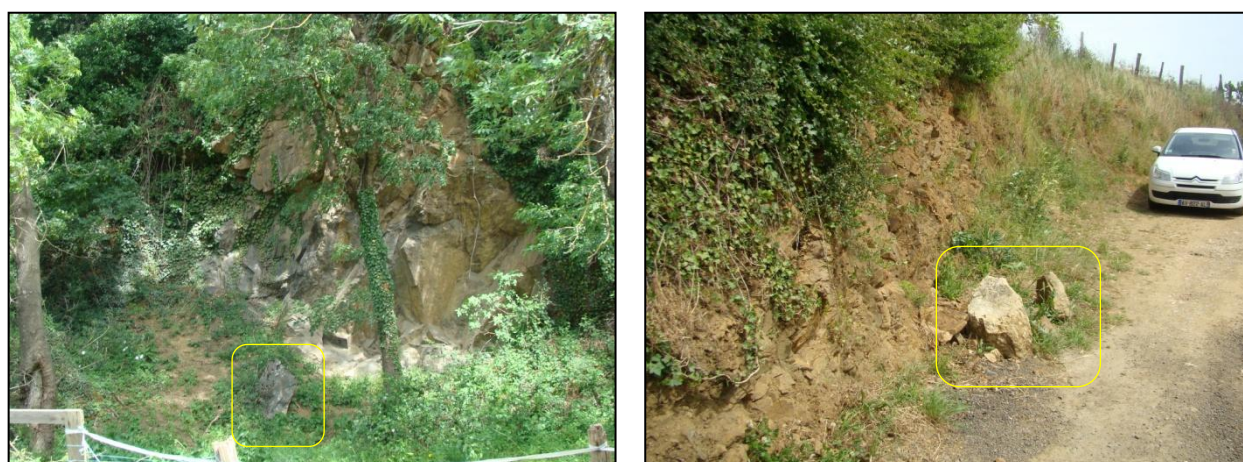
Figure 13 : Blocs éboulés de faibles dimensions, dans le secteur du Mont [Source : IMS RN ]
