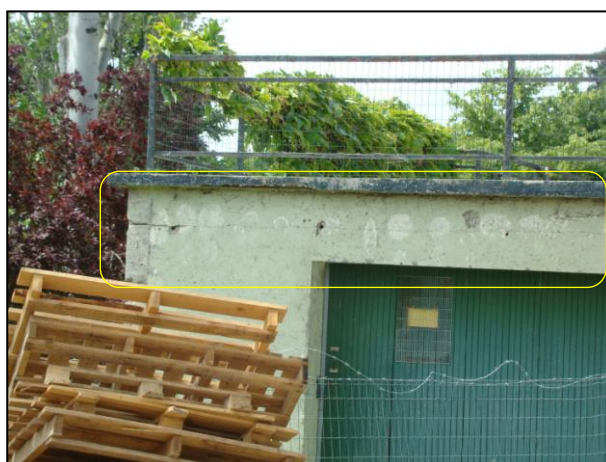
Figure 19 : Fissuration de la construction suite au mouvement des terrains vers l'aval [Source : IMS RN ]
