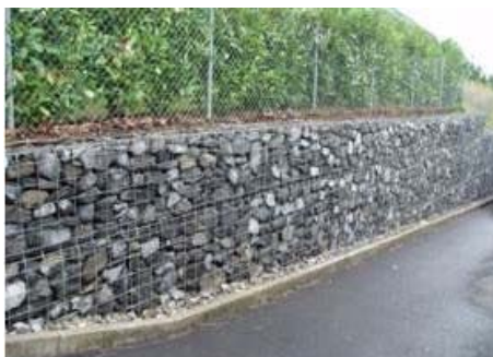
Muret en gabion
