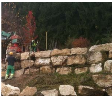
Enrochement de type cyclopéen
