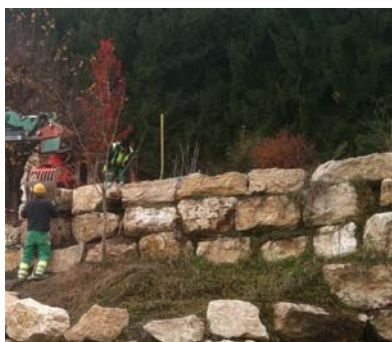
Enrochement de type cyclopéen
