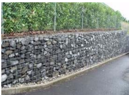
Muret en gabion
