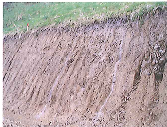
V38 - Z5 - Amont RD n° 25 - déblais (W)
