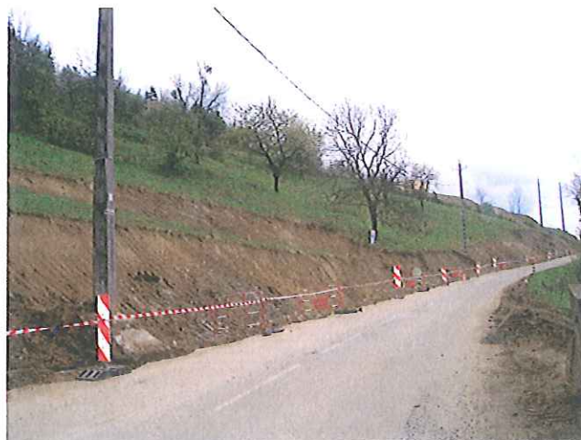
V37 - Z5 - Amont RD n° 25 - déblais (N)
