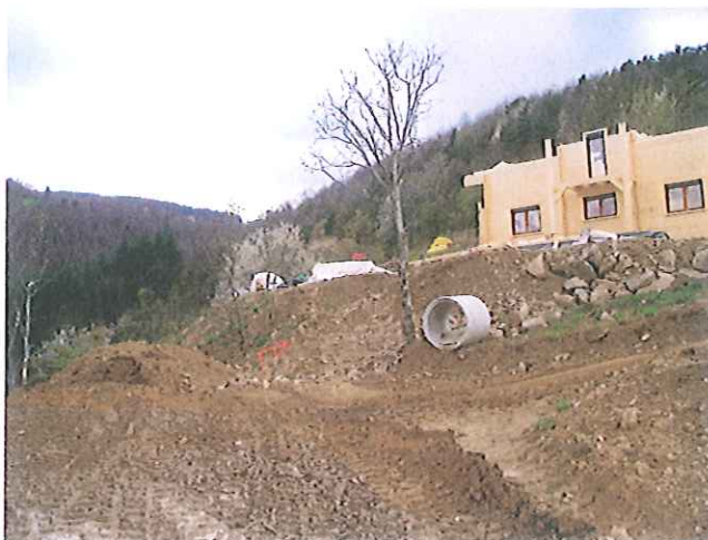
V42 - Z5 - Constructions amont RD n° 25 (S)
