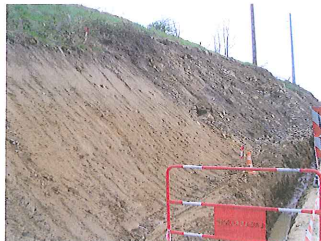
V39 - Z5 - Amont RD n° 25 - déblais (N)
