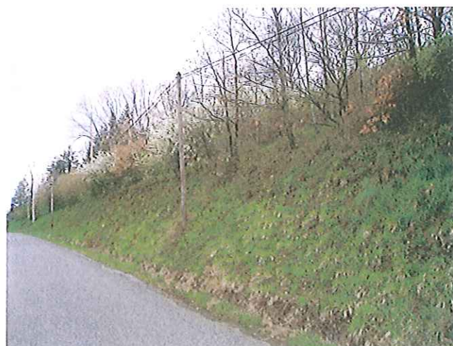
V21 - Z3 - Talus amont VC n° 8 (E)
