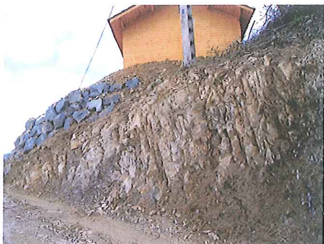
V41 - Z5 - Zone d'accès amont RD n° 25 (SW)
