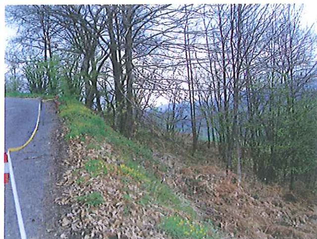
V49 - Z6 - Aval chemin (NE)
