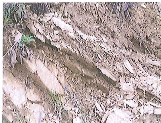
V52 - Z6 - Rocher altéré et fracturé (S)
