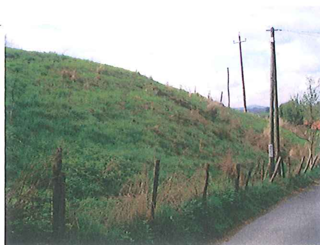
V35 - Z5 - Aval RD n° 25 (NW)
