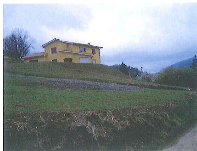
V28 - Z3 - Zone SW - amont chemin (NE)
