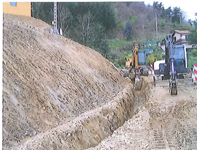
V40 - Z5 - Amont RD n° 25 - déblais (W)
