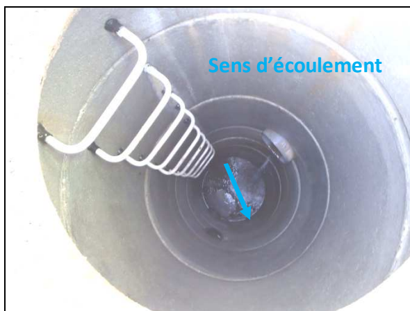
Regard n° 91 - Regard amont du bassin de rétention BR1 au Lotissement des Sources
