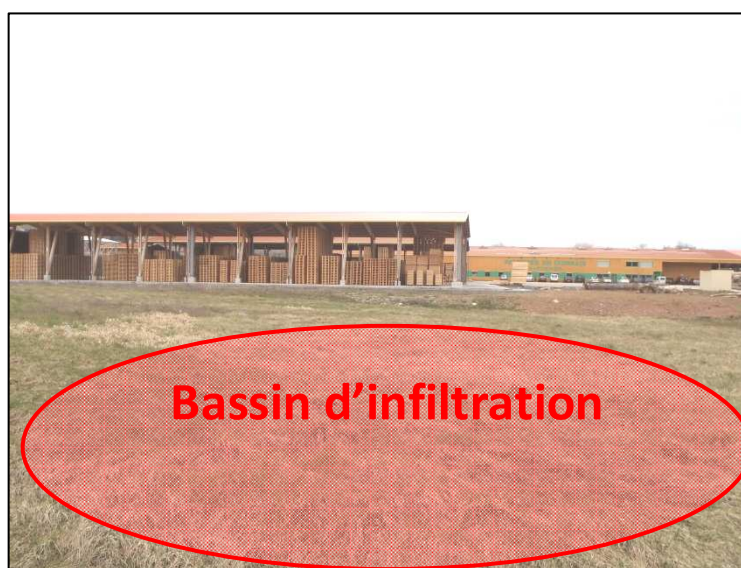
Bassin d'infiltration au droit de l'entreprise « Baronnier palettes du Lyonnais »
