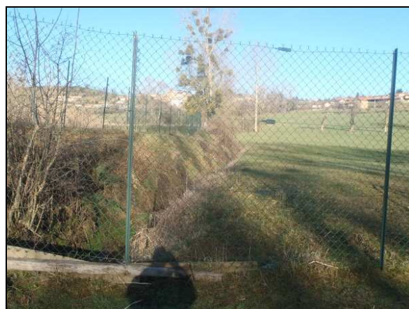
Exutoire du déversoir d'orage dans le ruisseau du Mezet
