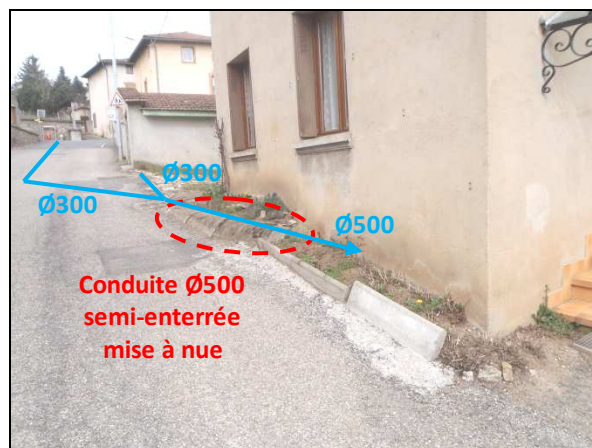
Conduite Ø500 semi-enterrée de la Rue du Bourg
