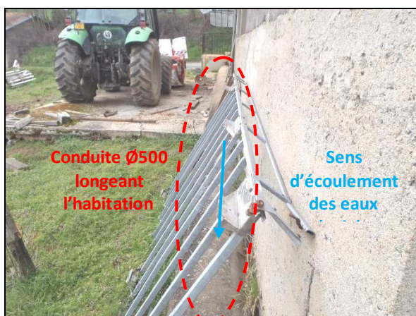
Conduite Ø500 le long de l'habitation
