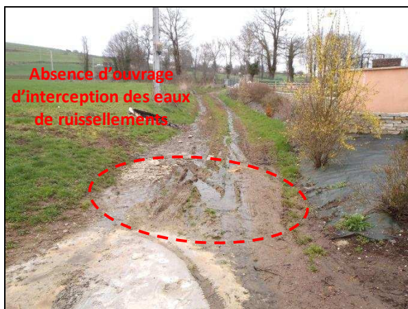
Zone de stagnation en amont d'une des buses Ø400 (photo prise en temps sec)
