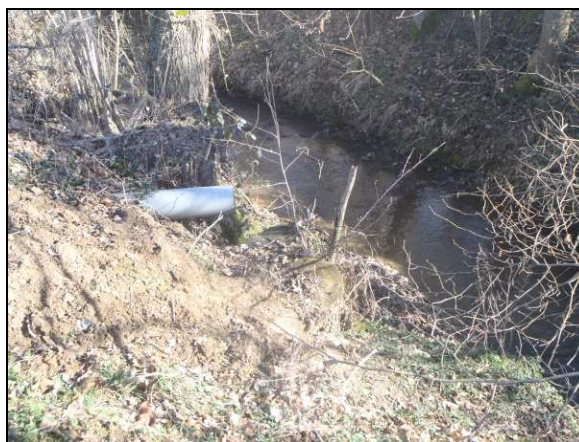
Point de rejet des eaux issues de la 3 ème lagune dans la Brévenne
