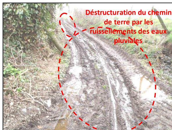
Photo 2 : En direction du Chemin du Lajay
