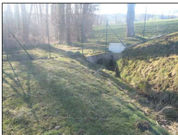
Rejet dans le fossé avant de rejoindre la Goutte de la Gagère
