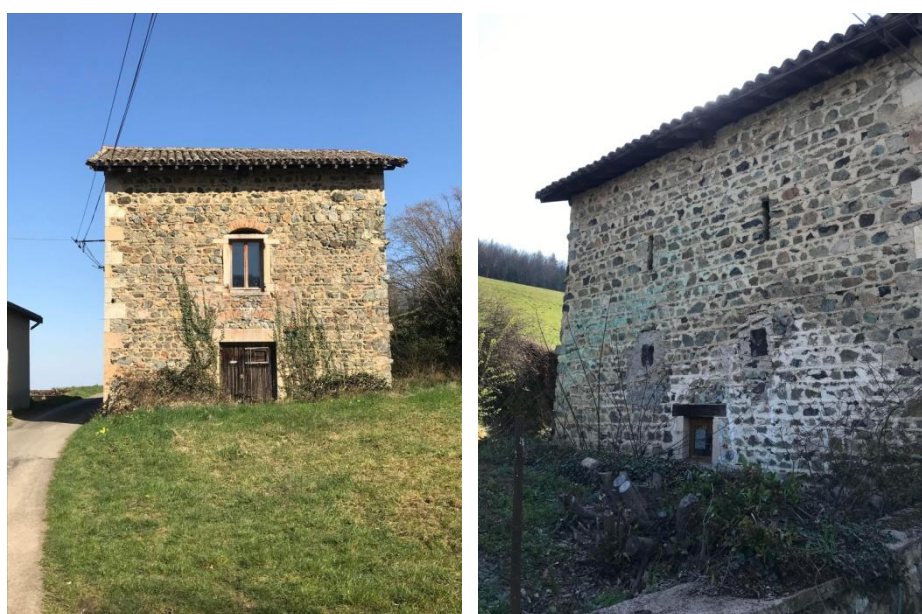
Différentes vue du bâtiment.
