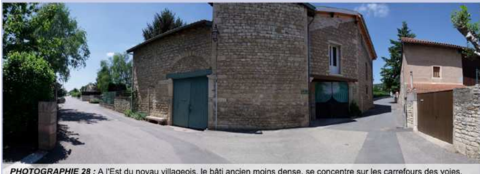
PHOTOGRAPHIE 28 : A l'Est du noyau villageois, le bâti ancien moins dense, se concentre sur les carrefours des voies.
