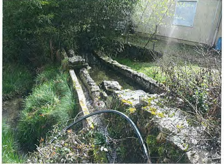
BASSIN PRIVE ALIMENTE PAR LE BASSIN VERSANT BACHELARD
