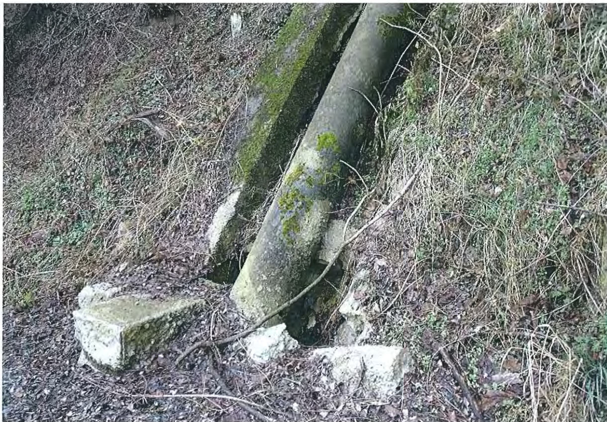
EXUTOIRE DU RESEAU EP
