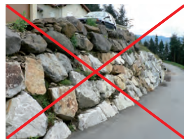
Exemple d'enrochements de type cyclopéen
