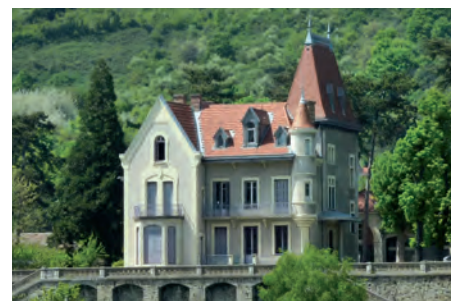
Exemple de toiture de maison bourgeoise
