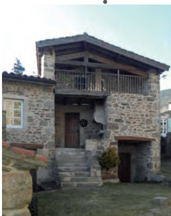
Exemple de débord de toiture
