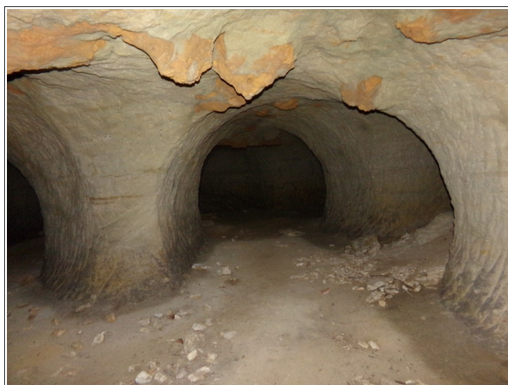
Figure IV 1: exemple de paquet de matériaux argileux suspendus au ciel de la cavité 2.
