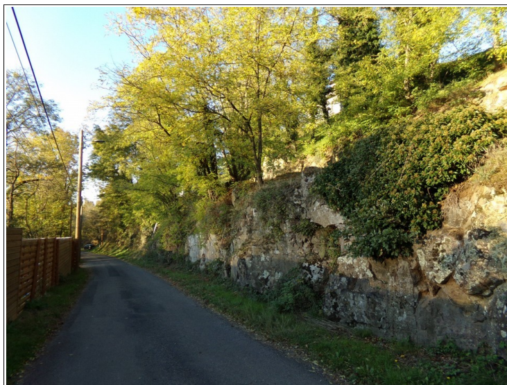
Figure III 9: exemple de talus rocheux le long de la voie du Tacot au lieu-dit Varina.
