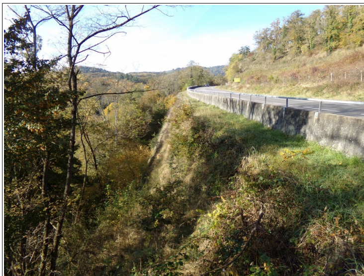
Figure III 8: ouvrage de soutènement de la RD 313 contenant une zone remblayée.
