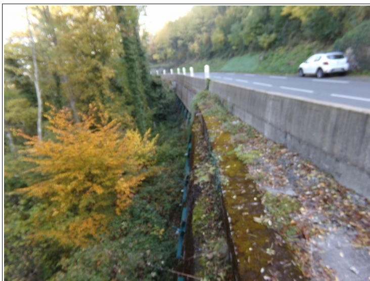
Figure III 4: ouvrage de soutènement de la RD338 au niveau du glissement de terrain des années 1990.
