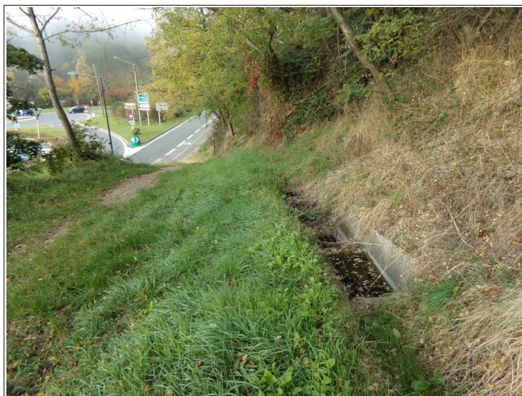
Figure III 1: fossé du chemin des Ecoliers en amont du hameau des Ponts-Tarrets
