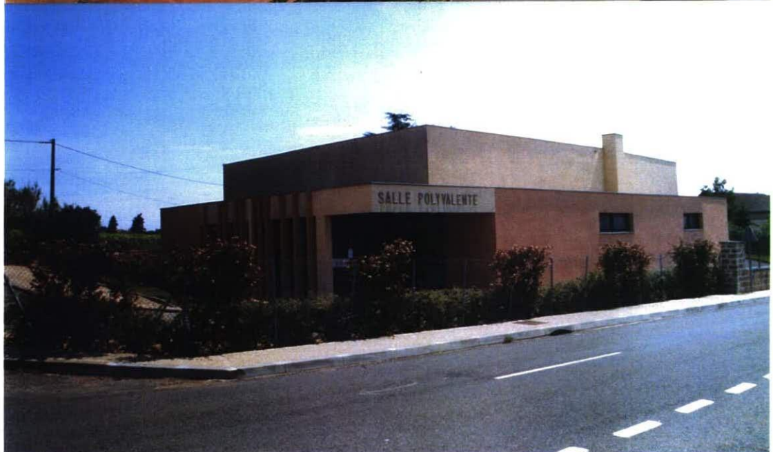
La salle polyvalente à l'entrée du village avec côté Est la bibliothèque et les locaux pour la vie associative
