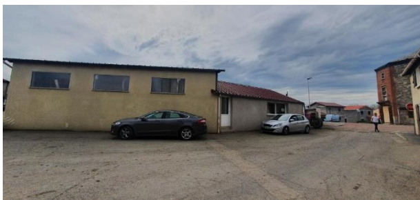
Espace voirie à redélimiter avec du stationnement à créer
