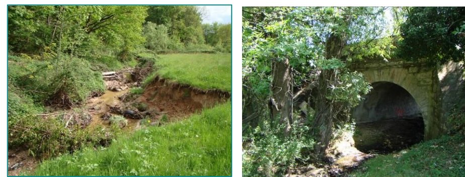
La Chaudanne : secteur d'érosion des berges
