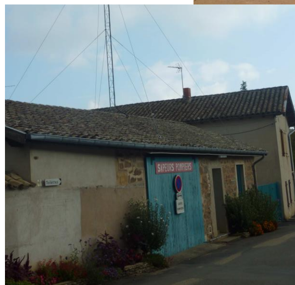
La caserne de pompiers
