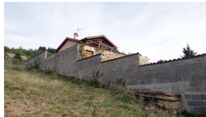
Mur de clôture en parpaings non enduit
