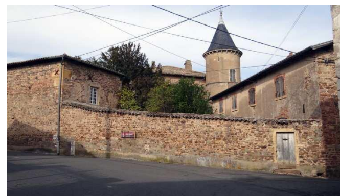
Réseaux aériens préjudiciables à l'image du château
