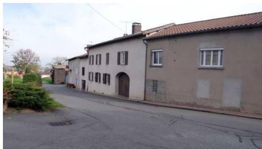
Front urbain traditionnel : l'alignement des maisons « tient » la rue
