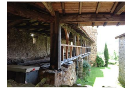
Exemple d'éléments bâti, apportant une plus valu paysagère importante au bourg
