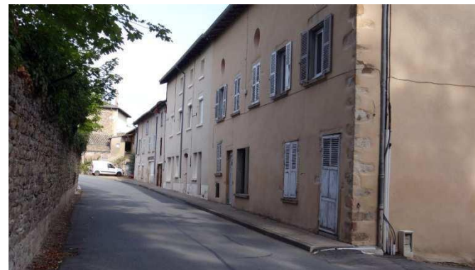
Fermeture des vues entre mur du parc et façades
