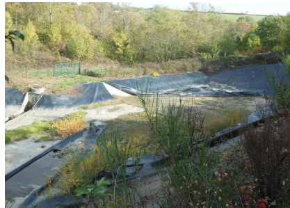
Bassin de rétention
