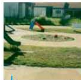
Aire de jeux avec puits d'infiltration central, Bordeaux
