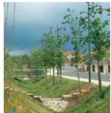
Noues cloisonnées, Parc Bouglione, Corbas
