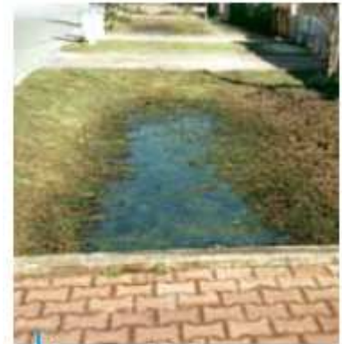
Noue en eau, Bordeaux
