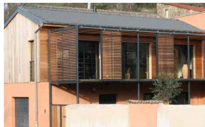
Exemple de loggia
