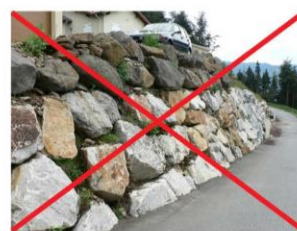
Exemple d'enrochements de type cyclopéen
