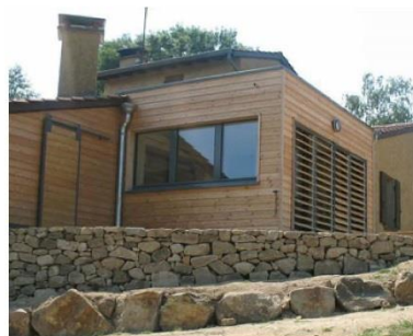
Exemple de lames orientables mobiles
