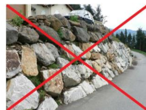
Exemple d'enrochements de type cyclopéen
