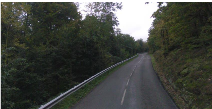
La RD103, entrée communale nord
