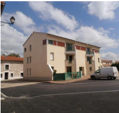
Immeuble La comtoise
