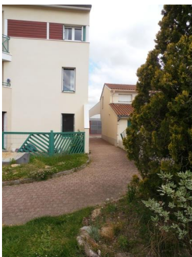
Accès créé dans le cadre d'un projet d'habitat, lien entre l'impasse de la comtoise et la route de la Croix Régis
