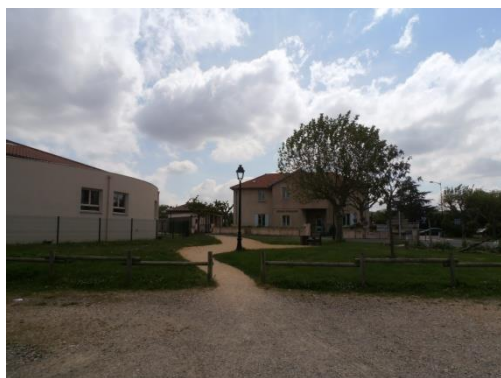
Accès créé dans le cadre d'un projet d'habitat, lien entre la rue des écoliers et la route de Givors
