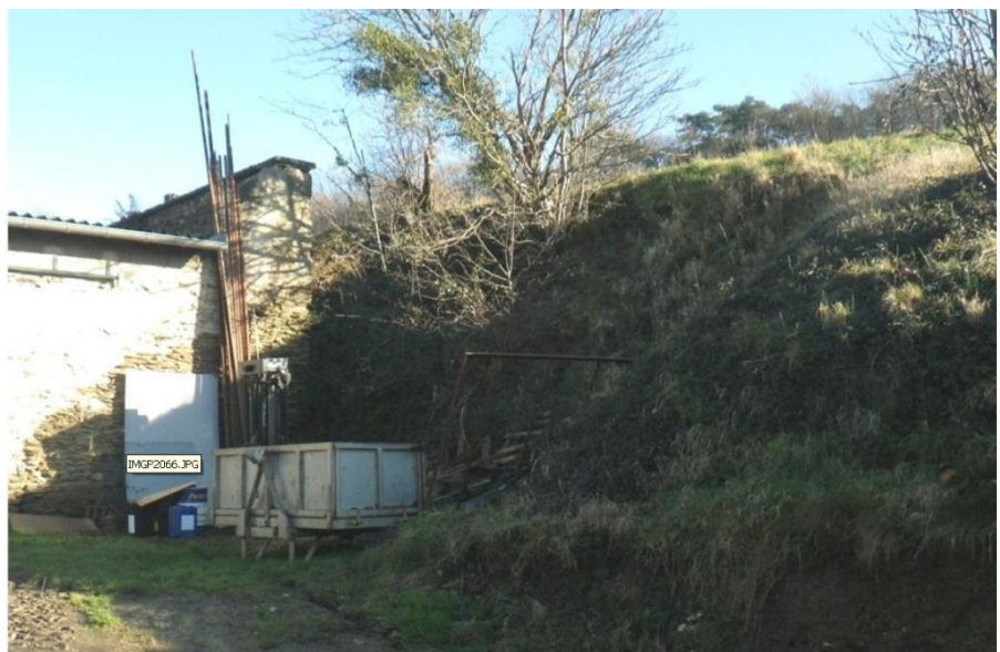
Vue du talus à Poirieux
