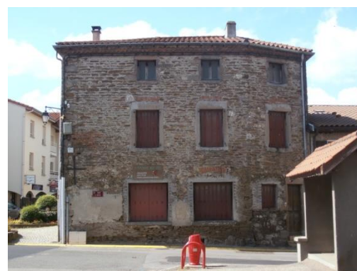
Logement inoccupé - Route de Trèves
