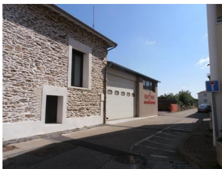
Caserne des pompiers
