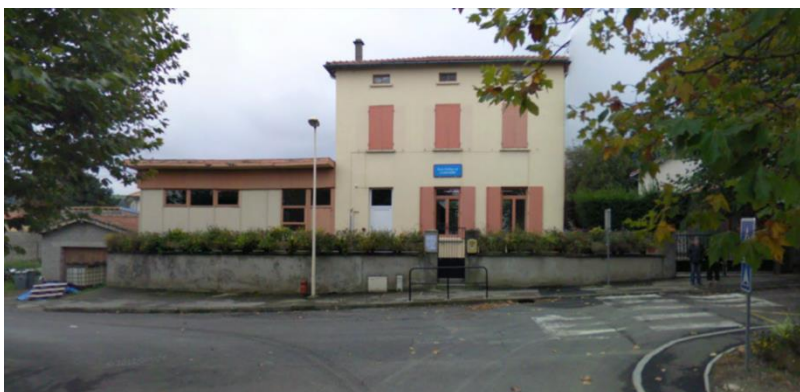
Ancienne école et aménagement d'un trottoir au droit du bâtiment
