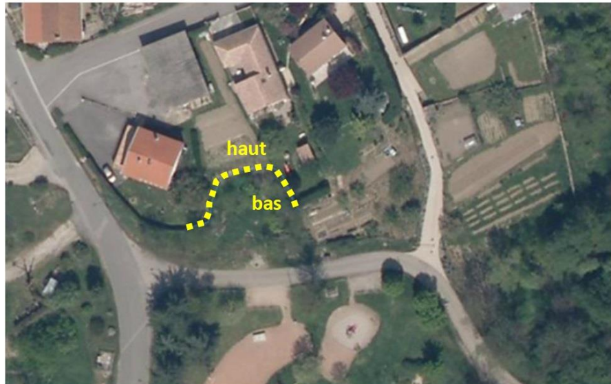
Localisation du front rocheux, route du Pré
